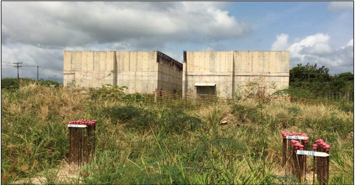
Figura 9 – Obras da ETE UNA.
